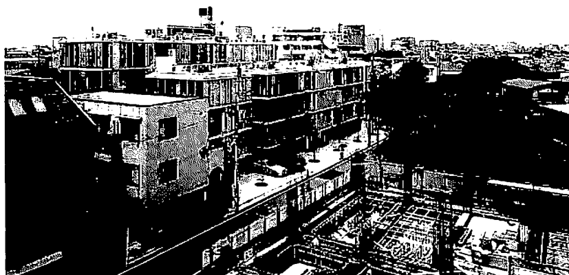
西方向を見る。周辺には閑静な住宅街が広がる。第一種低層住居専用地域となる敷地北側の道路側は4階建て、準住居地域となる南側は5階建てとした
