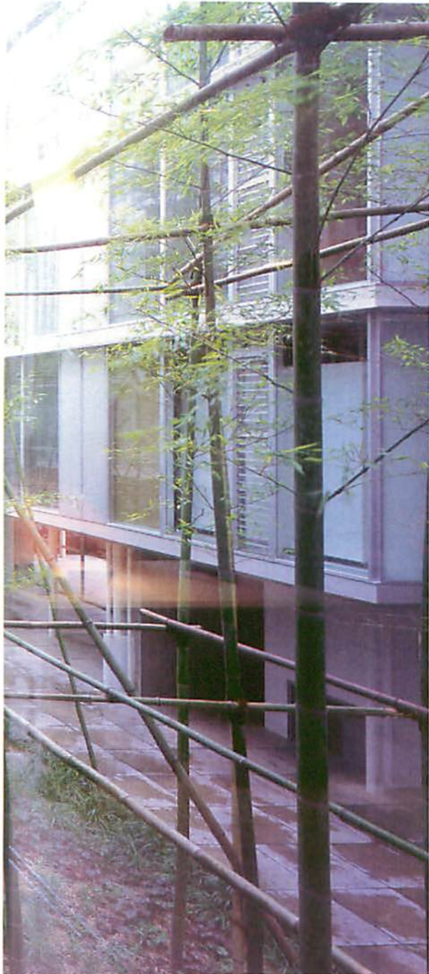
前面道路から見る。一辺7.2mと8.1mの正方形の住棟が道路に沿って5つ連結する。可動建具でふさいでないガラス面は室内が丸見えだ。カーテンを使用する場合は事業者が色やメーカーを指定する約束になっている
