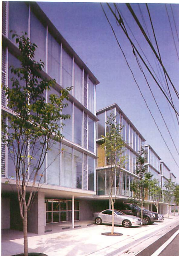
前面道路から見る。一辺7.2mと8.1mの正方形の住棟が道路に沿って5つ連結する。可動建具でふさいでないガラス面は室内が丸見えだ。カーテンを使用する場合は事業者が色やメーカーを指定する約束になっている
